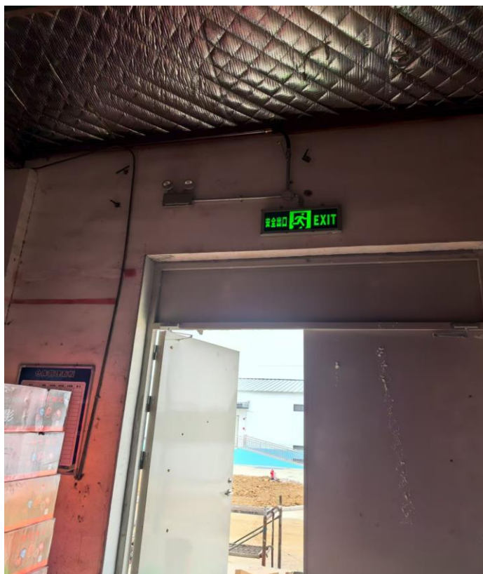
附图 4：老仓库已增设应急疏散照明。
