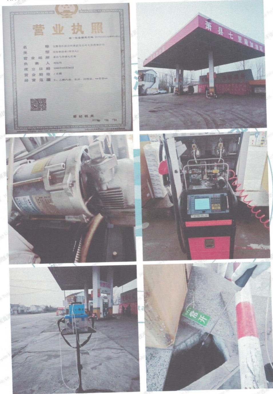
附件 1: 现场检测照片
